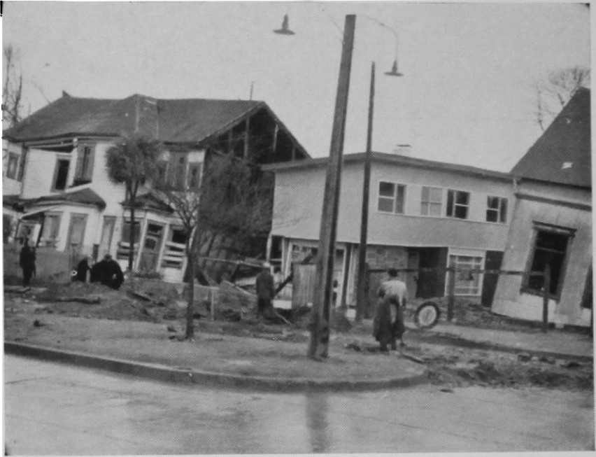
Valdivia: Daños en calle Picarte y dentro de zona con relleno artificial
