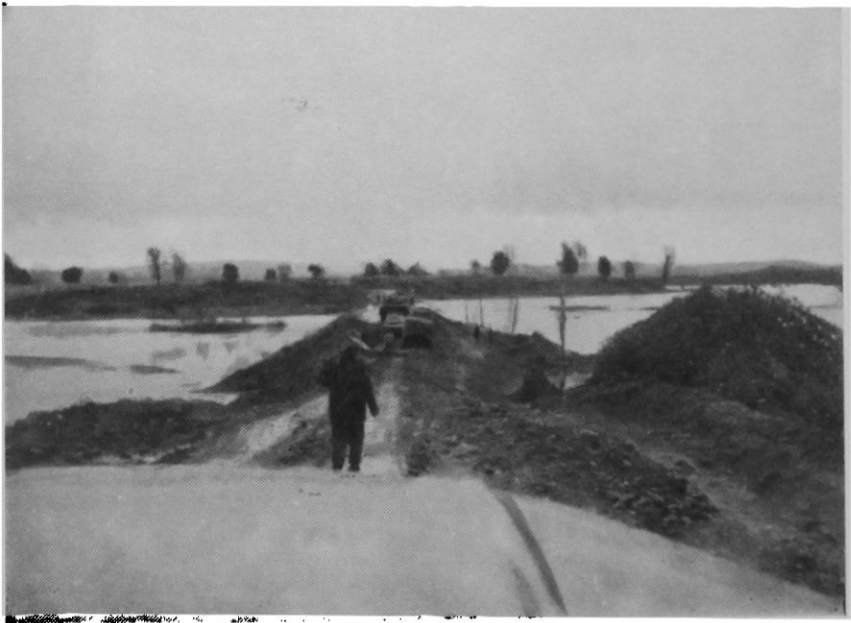
Valdivia: Camino de San José de la Mariquina a Valdivia. Destrucción Puente Pichoy
