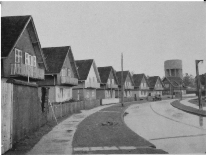
Valdivia: Población Nueva ubicada en cercanías Hospital Regional. La Población, prácticamente sin daños, está asentada en terreno natural. El estanque elevado, al fondo, sufrió muy graves perjuicios
