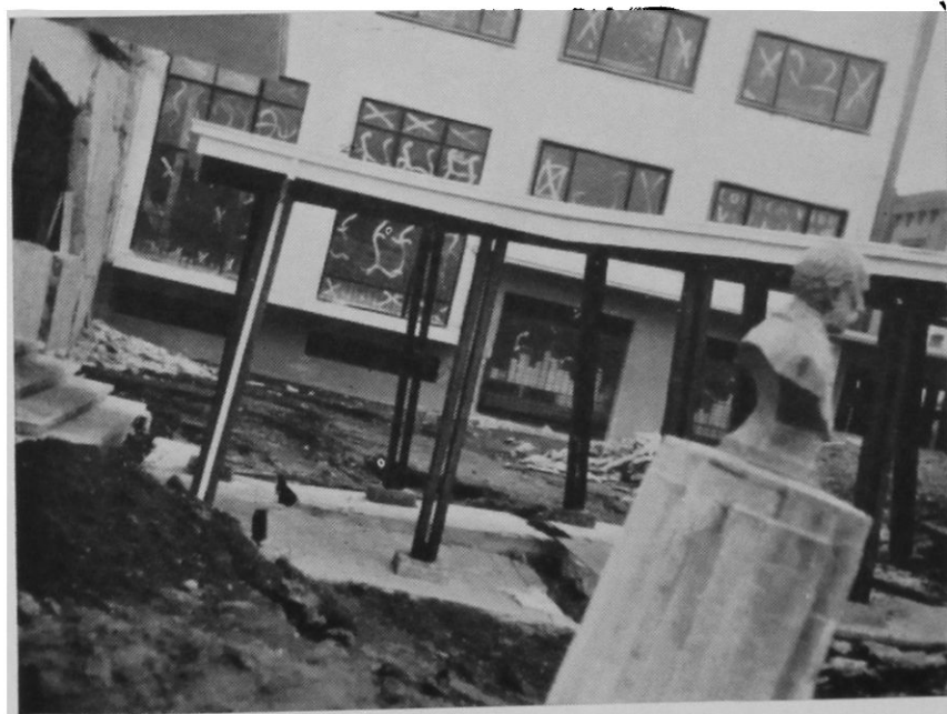
Puerto Montt: Daños en Hotel de Turismo en zona de relleno artificial
