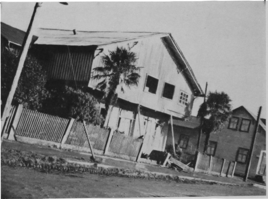
Río Negro: Calle principal de Río Negro. Aun las casas de madera aparecen fuertemente dañadas
